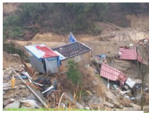
十二平地区の被災情況。
