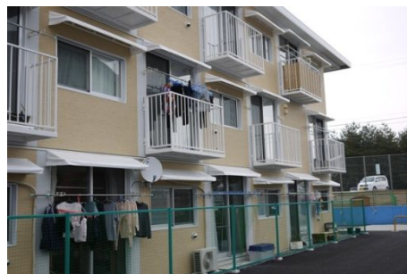
坂茂氏が提案・設計した3階建仮設住宅
